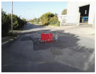
la presenza di un foro nella pavimentazione stradale che nasconde un completo svuotamento del corpo stradale sottostante. Alla luce di tale nuova situazione, si è provveduto con carattere di somma urgenza alla chiusura al traffico del tratto stradale interessato con altro procedimento amministrativo in corso.
