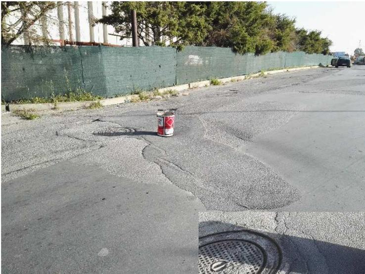
dei tombini, a cui si è aggiunta la presenza di un foro nella pavimentazione stradale che nasconde un completo svuotamento del corpo stradale sottostante.
