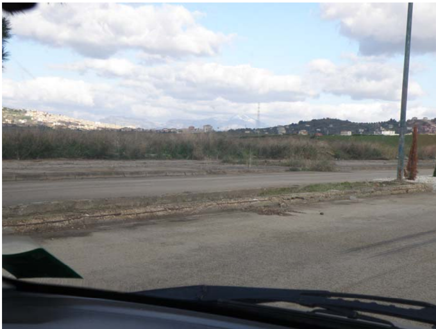
Foto n.16 – Ripristino cordolo spartitraffico degradato
