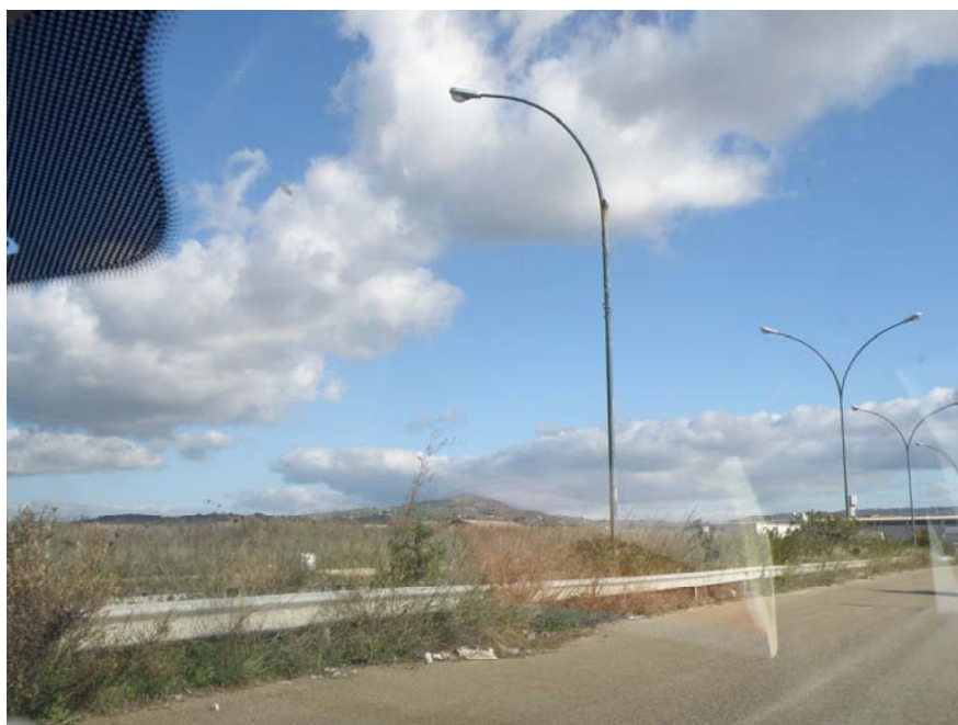
Foto n. 21– Palo di illuminazione
