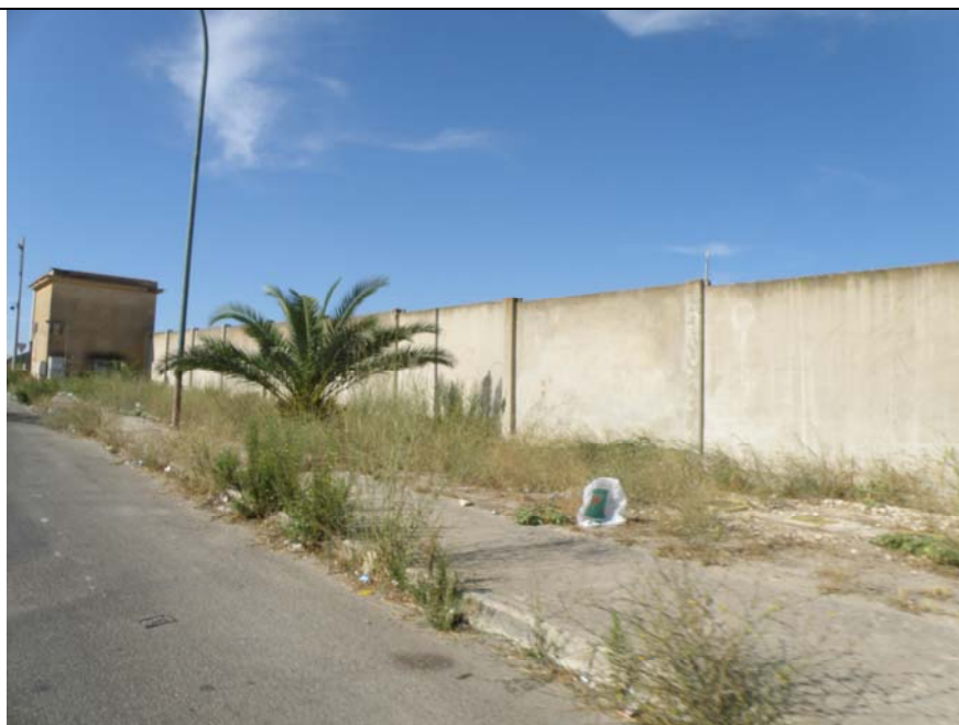
Foto n. 31 – Fascie di rispetto da pulire
