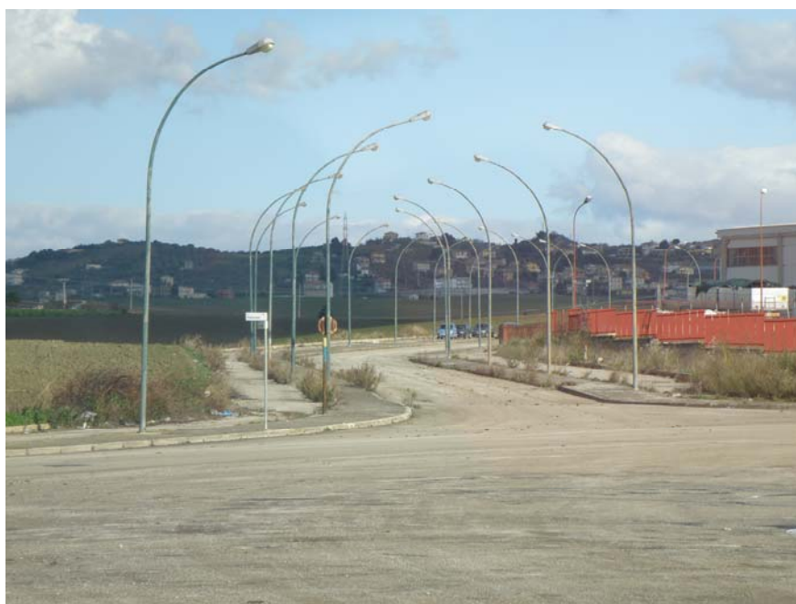
Foto n.8 – Viabilità interna all'area industriale
