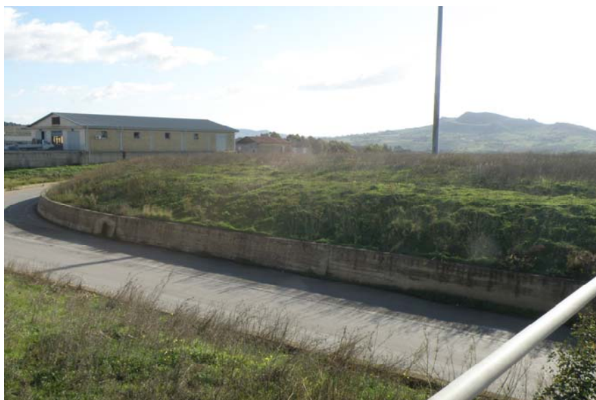
Foto n.2 – Svincolo accesso area industriale dalla ex SS 189
