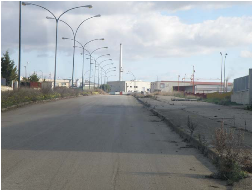
Foto n.9 – Viabilità interna all'area industriale
